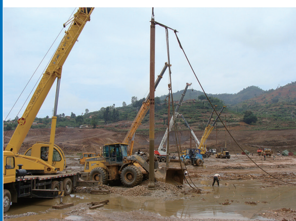
Yunnan Dazhuang Dam vibroflotation project 云南大庄水坝振冲工程
